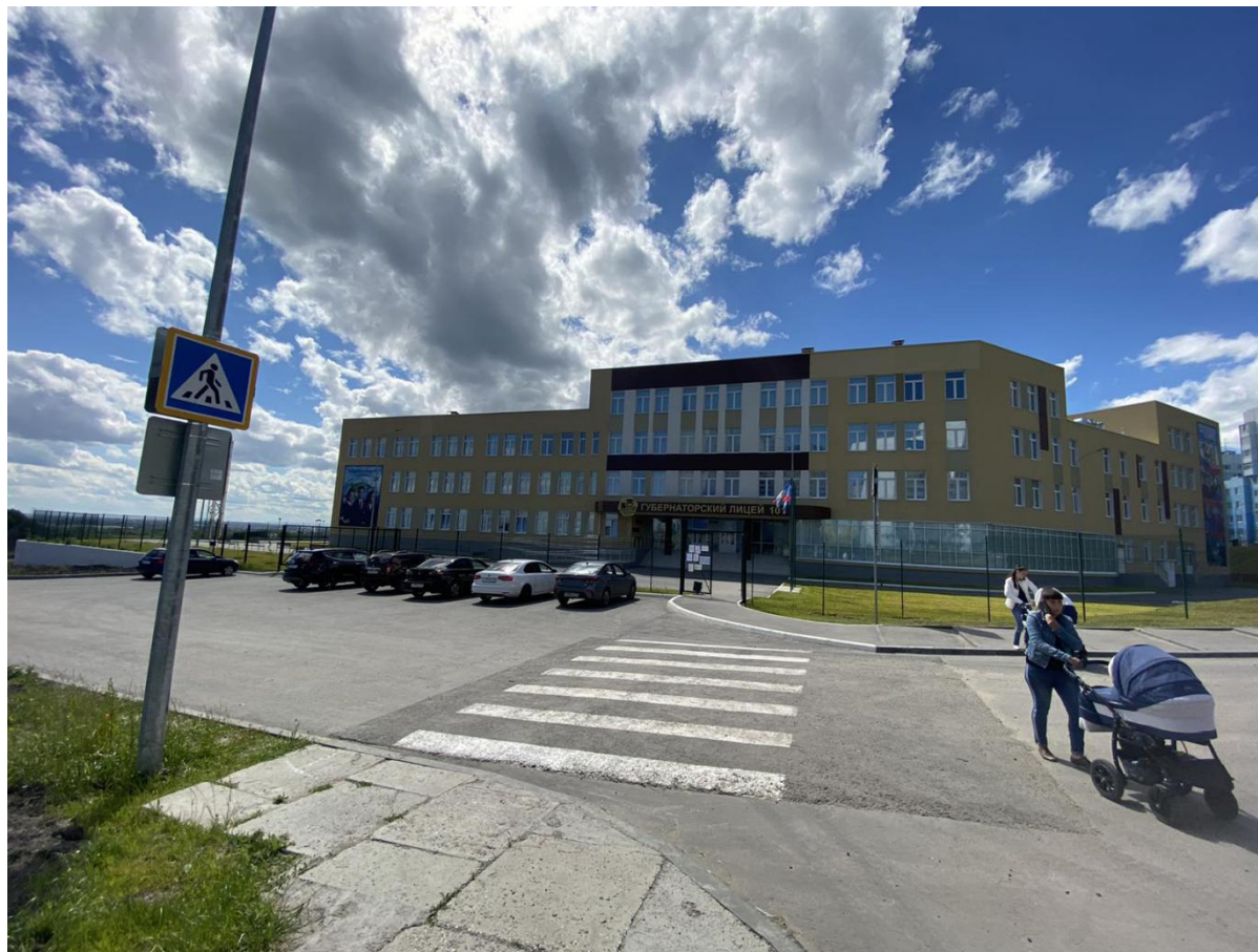
Пути подъезда к зданию МБОУ г. Ульяновска «Губернаторский лицей № 101»
